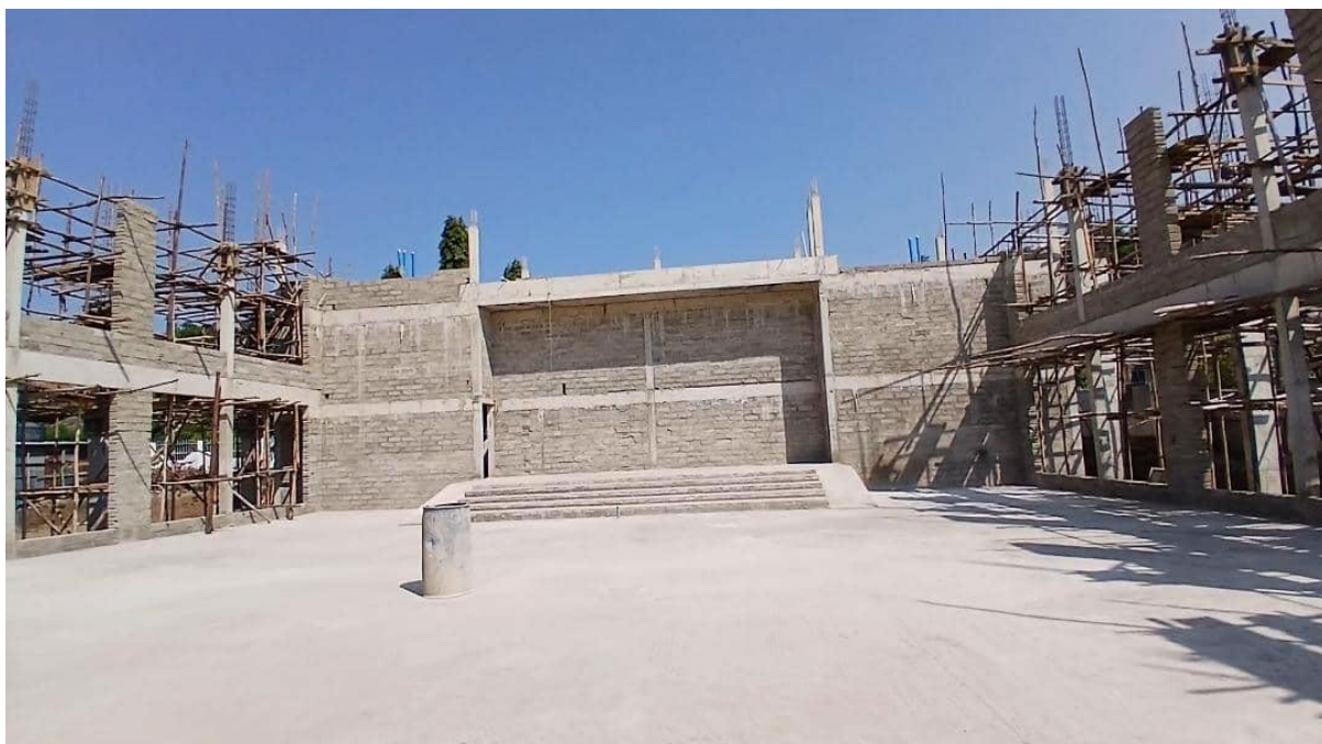
Picha 20: Jengo la Kanisa la Waadventista wa Sabato Buzuruga ambalo ujenzi wake unaendelea.
